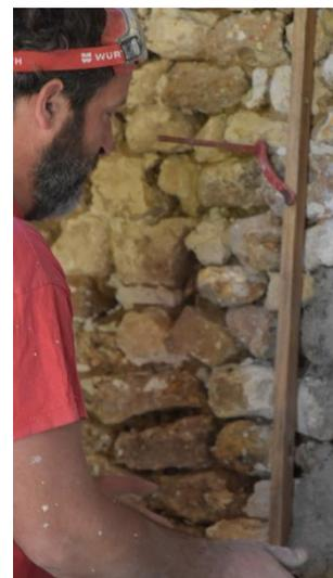
Enlever les excédents à la truelle, et avec la taloche à clous : ce talochage créera une accroche mécanique, et redressera un peu le mur en enlevant les surépaisseurs (sur un enduit fait de la veille, du moins avec du bâtichanvre). Ne pas appuyer, ce sont les clous qui font le travail. Puis mettre la règle pour voir les manques.
