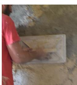
Ecraser l'enduit sur la taloche à l'épaisseur qu'on veut poser (2cm environ par exemple). Le reprendre avec la truelle et le projeter.
